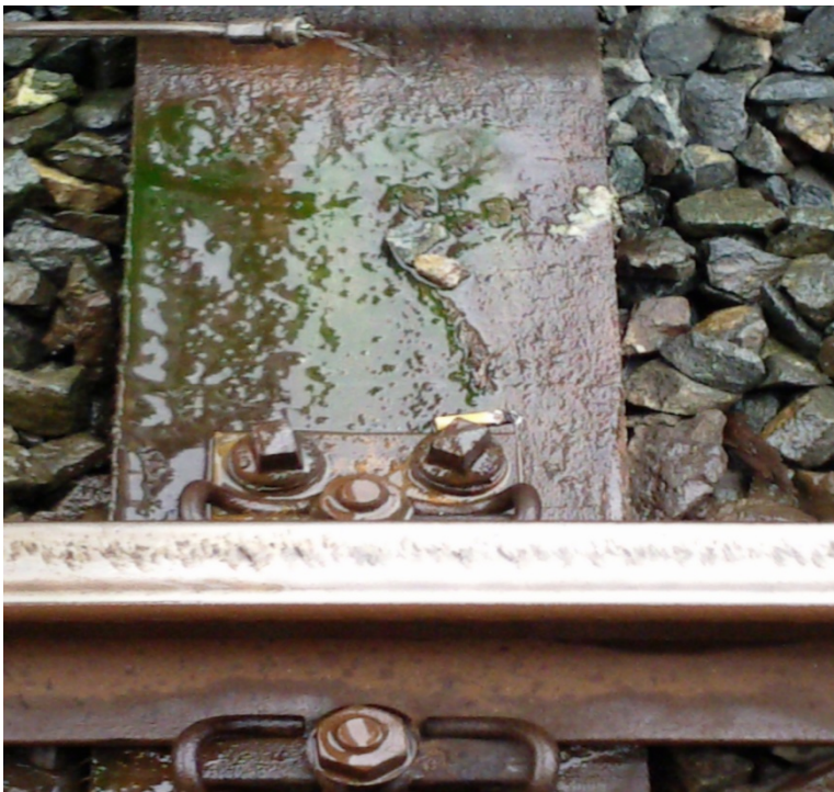
Abbildung 11: Schwelle mit Sprinkleranlage
