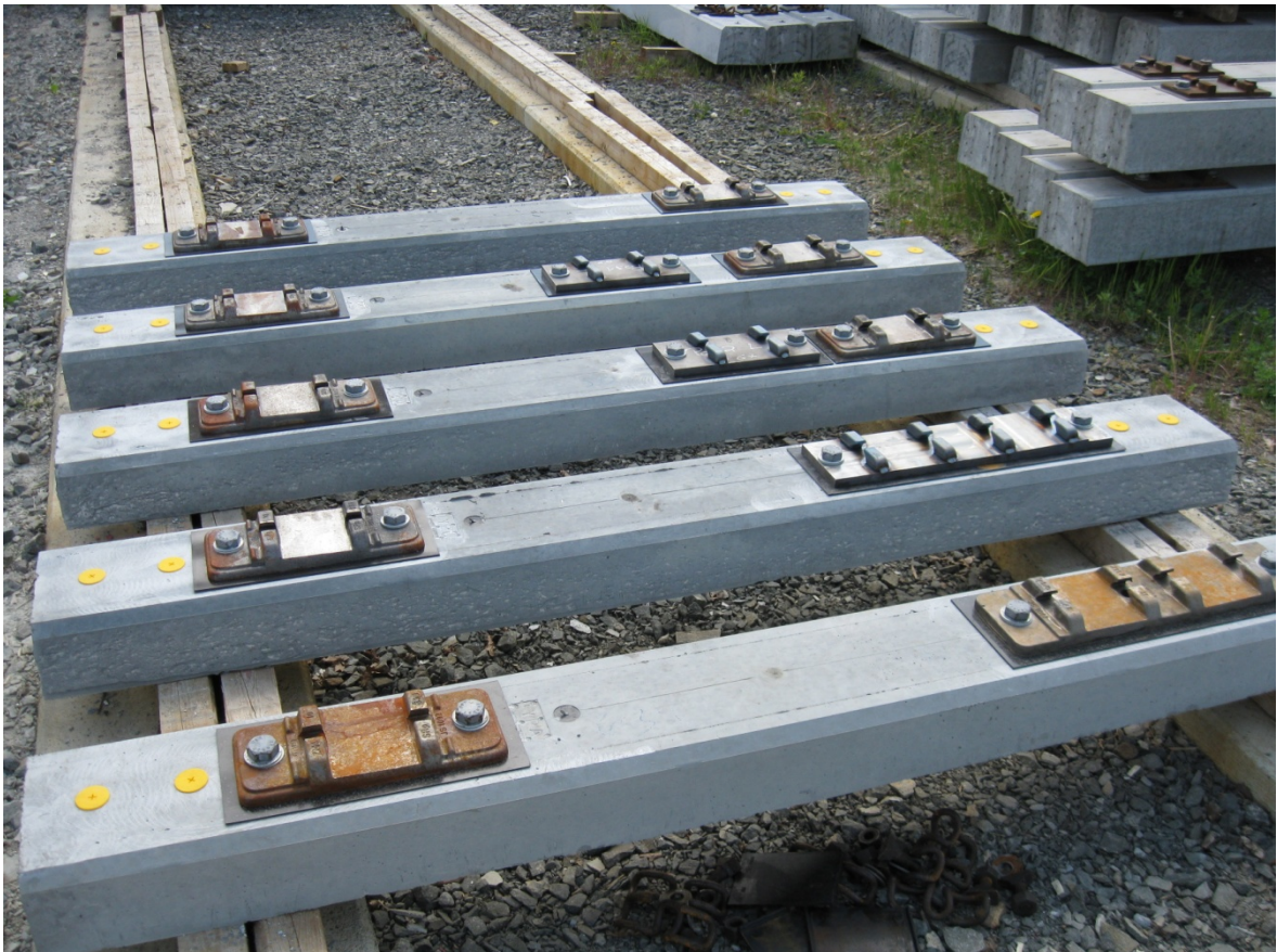
Abbildung 10: Spanntonschwelle für Führungsschiene
