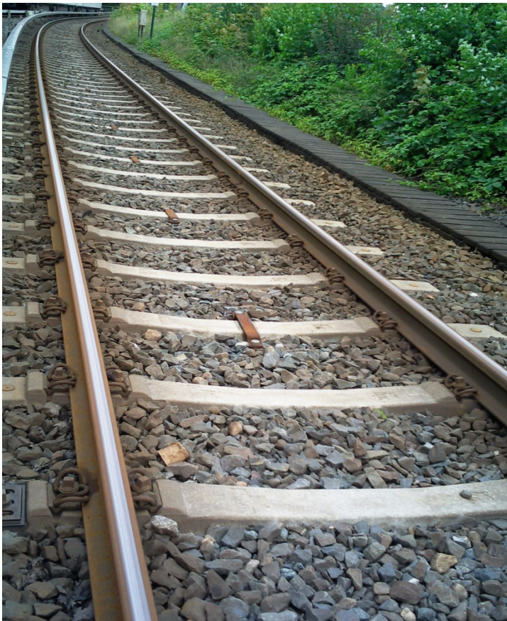
Abbildung 12: Betonschwellen im Netz der HOCHBAHN
